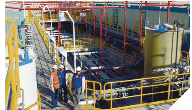
奥图泰为智利Escondida成功执行的VSF®技术。VSF®技术能够在不影响反应和澄清速率的同时把夹带最小化，这帮助Escondida获得世界上最大的浸出母液处理流量，超过5000m³/小时/单系列。
