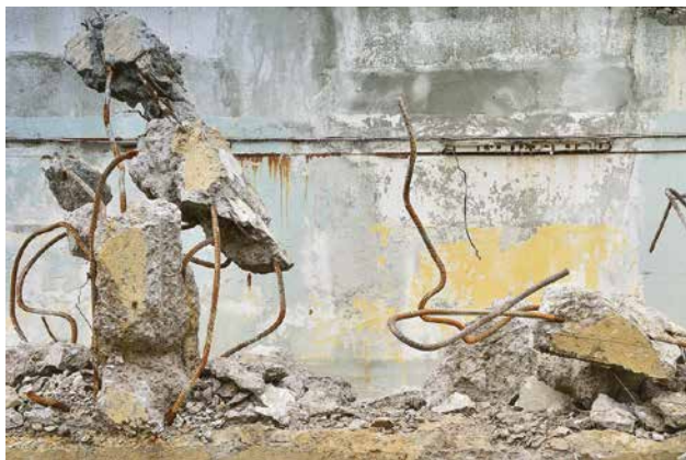
混凝土回收利用
